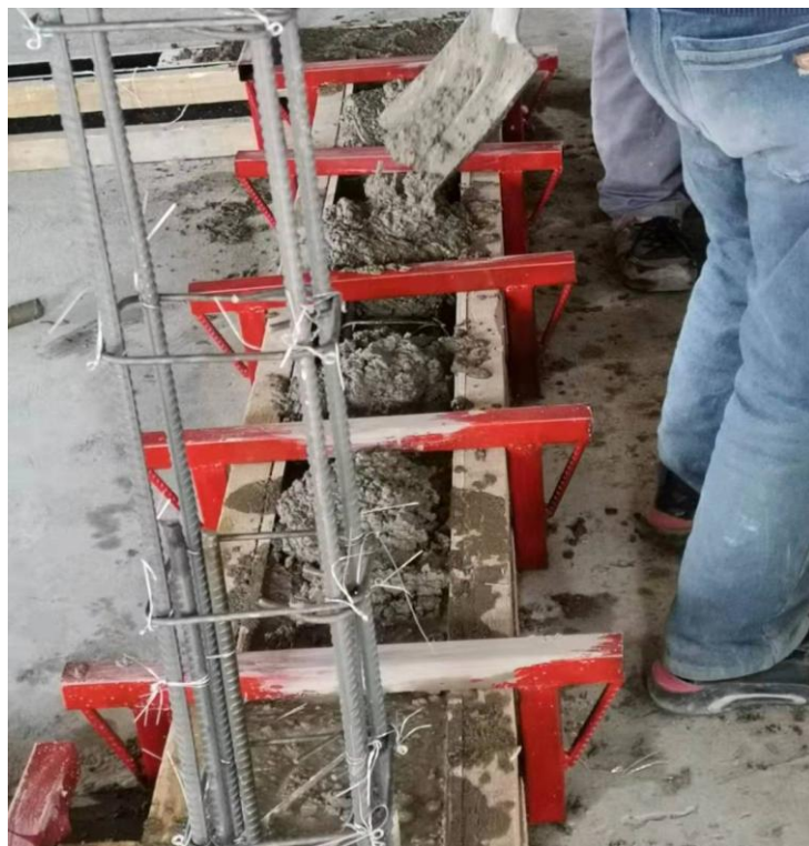
图四 混凝土施工
