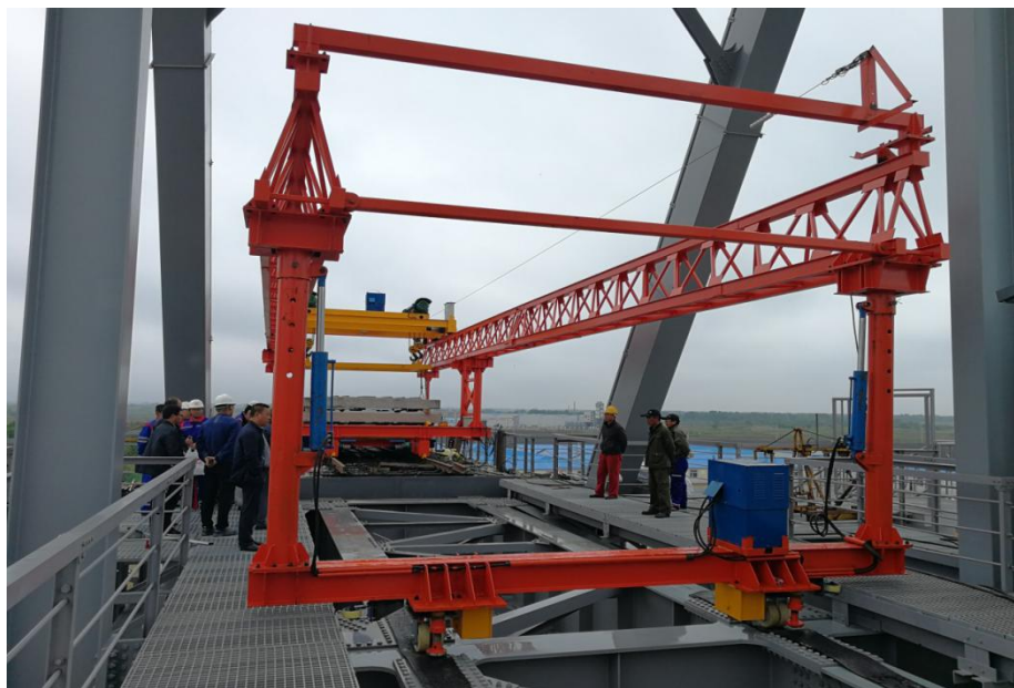
5. 四线套轨无砟轨道铺板机就位照片
