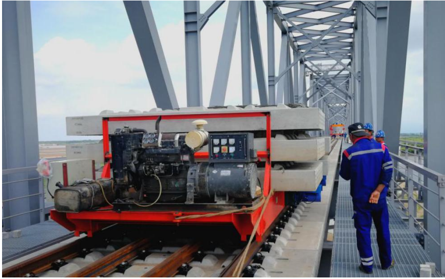
3. 四线套轨无砟轨道板上运输照片
