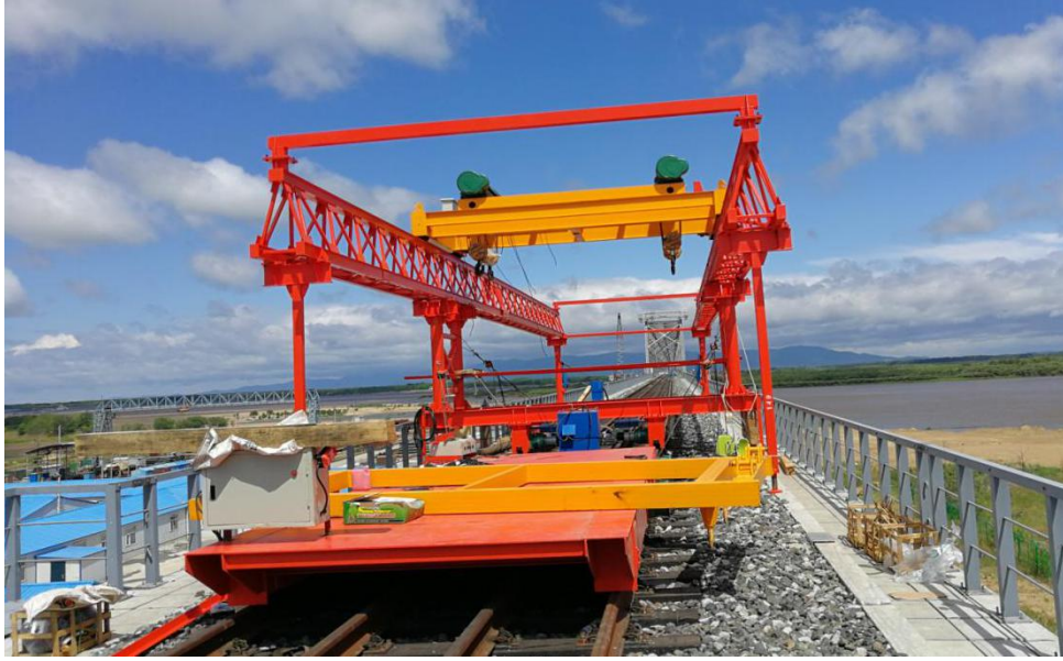
1. 四线套轨铺板机组装照片
