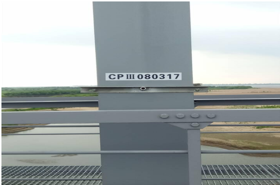
2. CPⅢ测量网的设定照片
