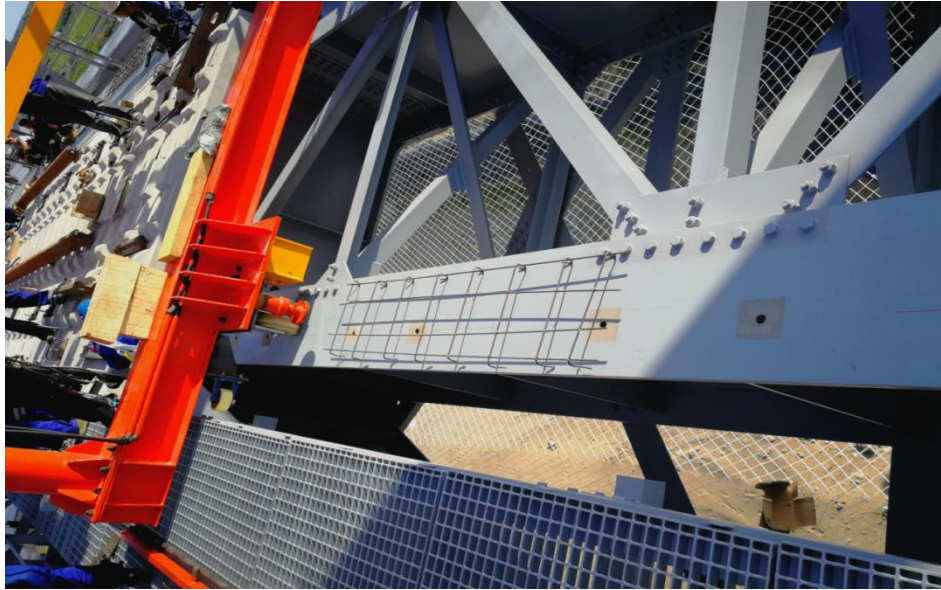
7. 四线套轨无砟轨道板下钢筋网片安放照片
