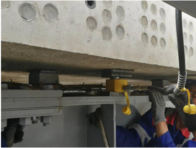
9. 四线套轨无砟轨道板就位精调标高照片
