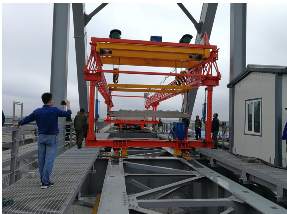
6. 四线套轨无砟轨道铺板机架板运输照片
