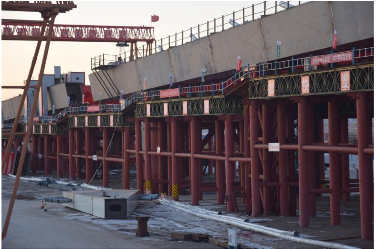
1、顶推设备进行导梁
