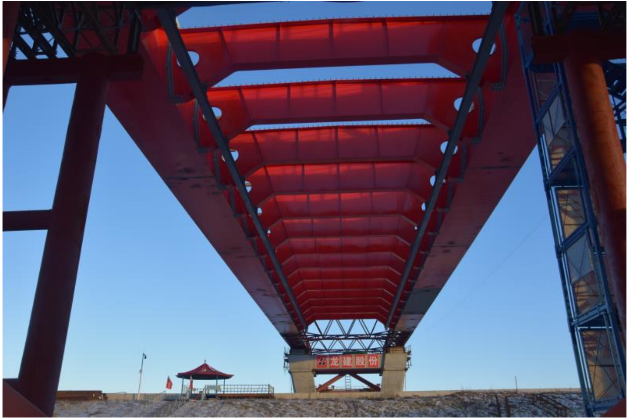
7、钢梁多点自平衡步履式顶推
