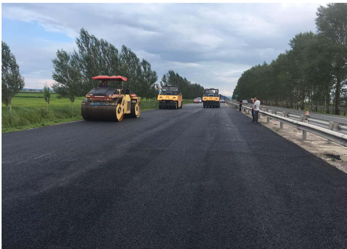
8. 融冰 SMC 超薄磨耗层双钢轮压实
