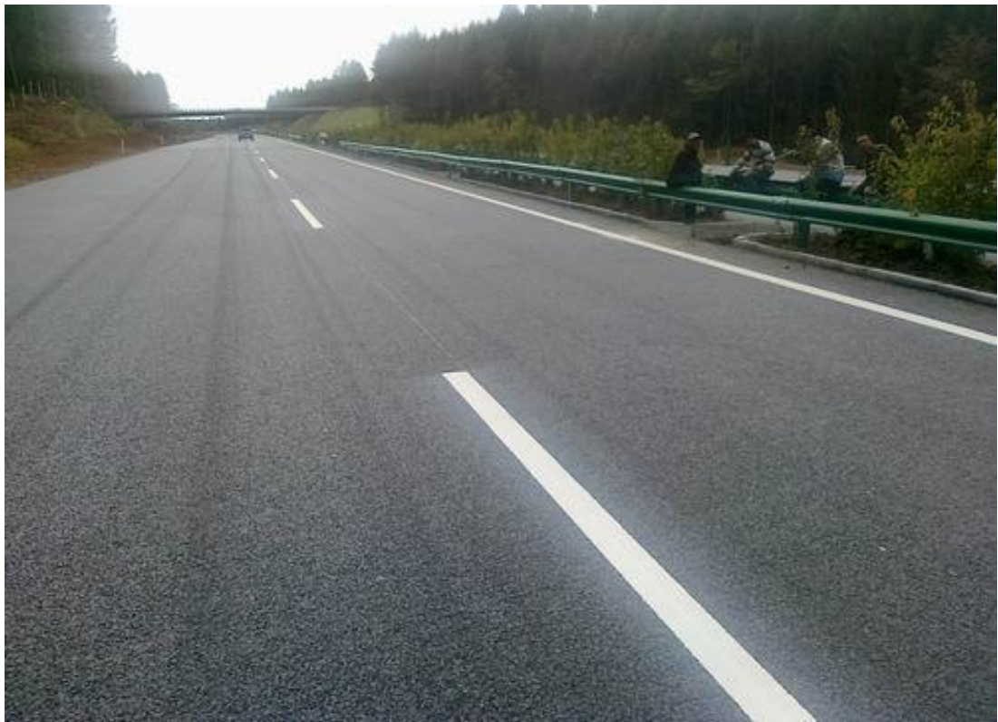
10. 施工结束照片
