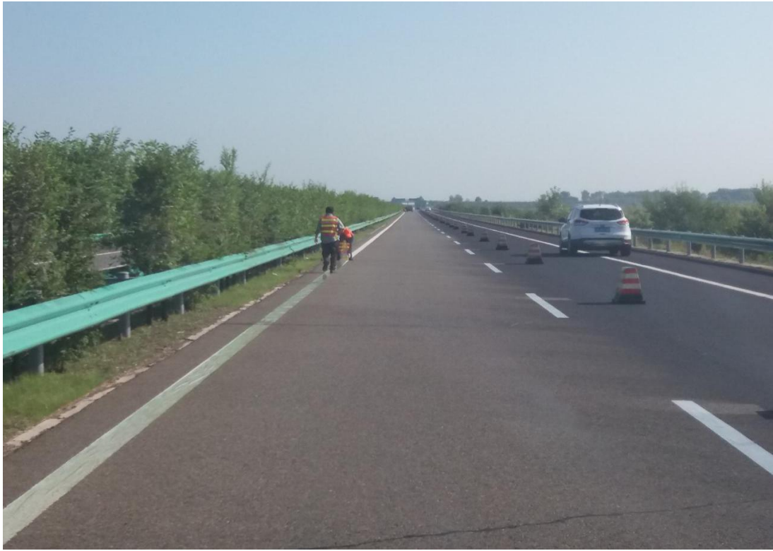
1. 安全封道施工
