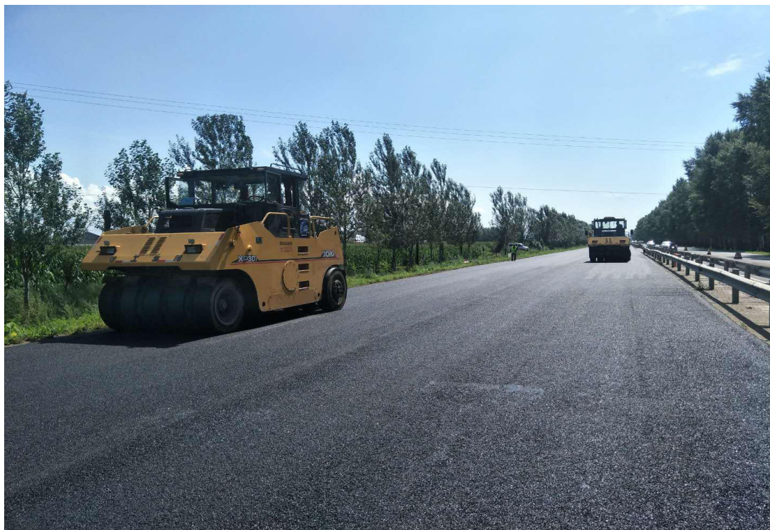
7. 融冰 SMC 超薄磨耗层重胶轮压实
