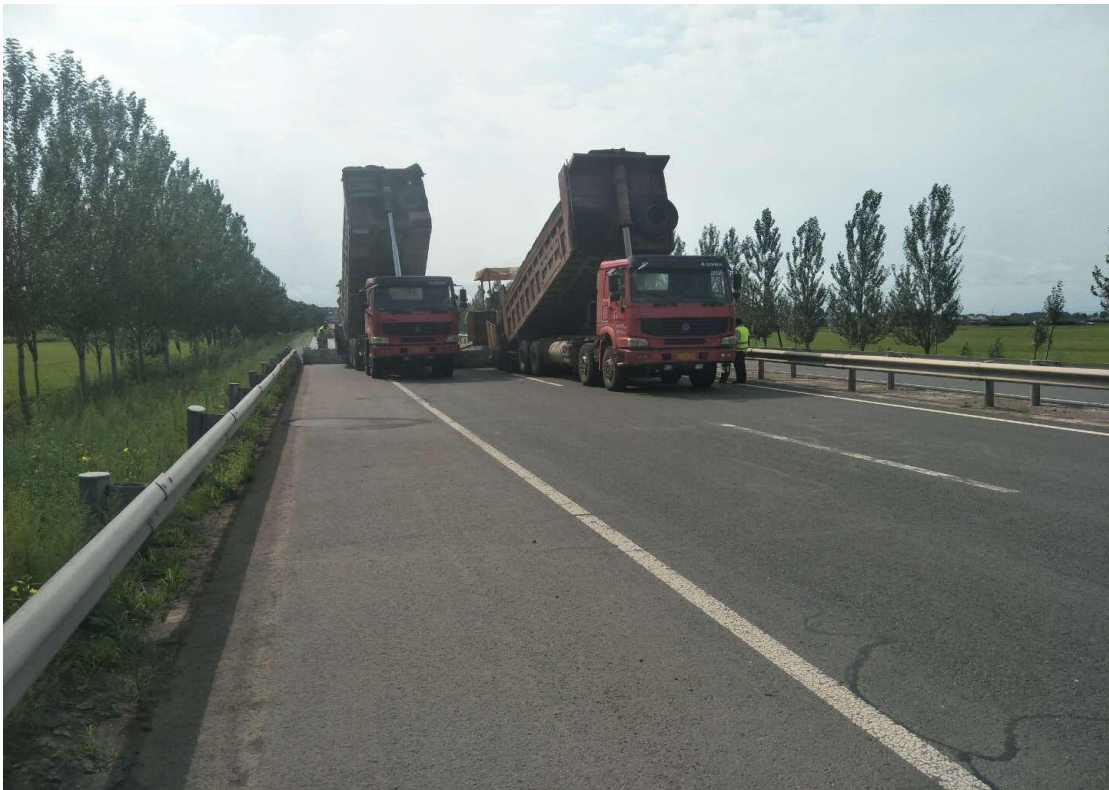
6. 融冰 SMC 超薄磨耗层摊铺
