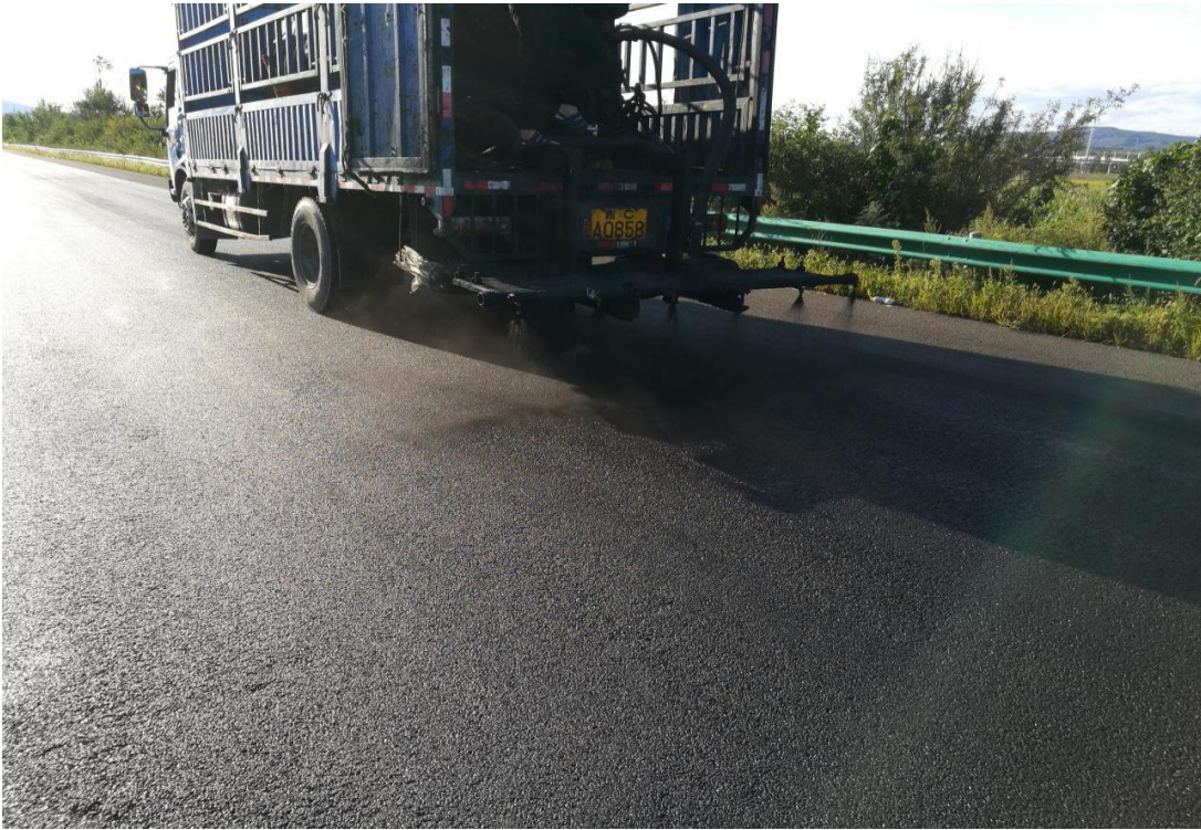
9. 融冰胶体矿物乳化封层施工
