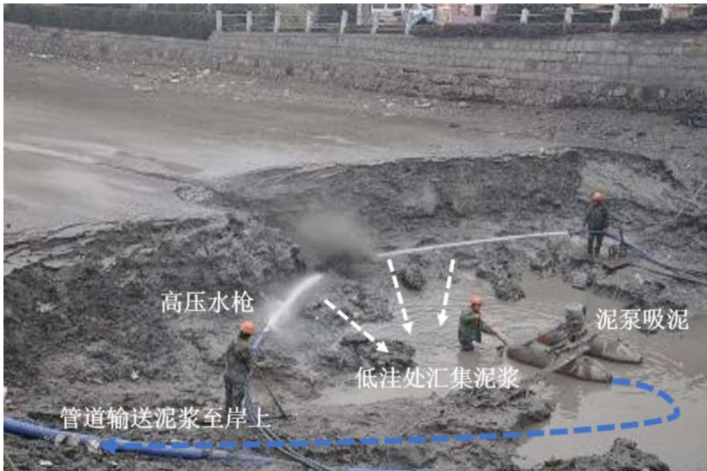
图3.1-16 水力冲挖清淤现场图
