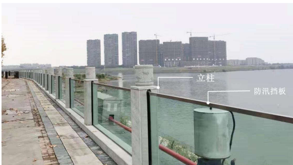
图3.4-5 护栏式防洪墙
