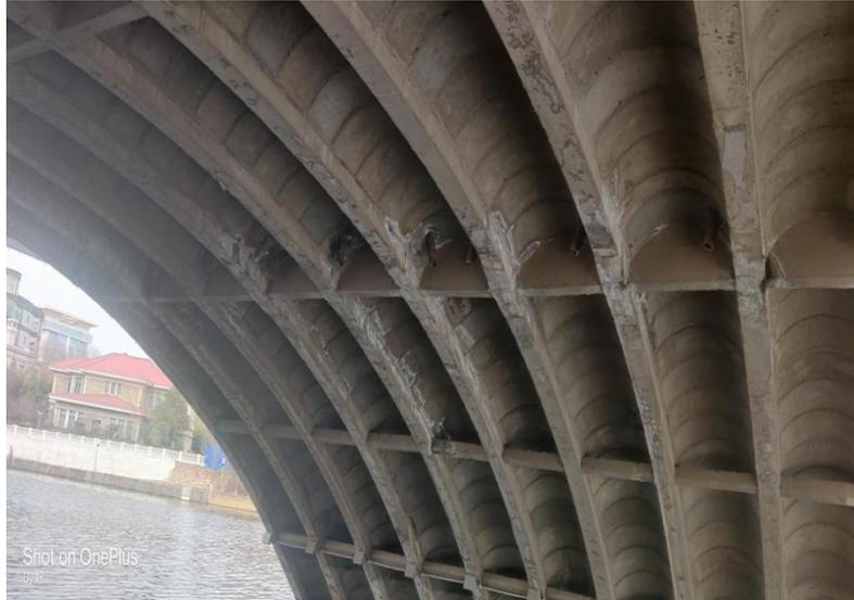
图 3.2.4-5 主拱圈病害检查
