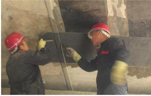
图 4.3-8 粘贴碳纤维布加固桥梁
