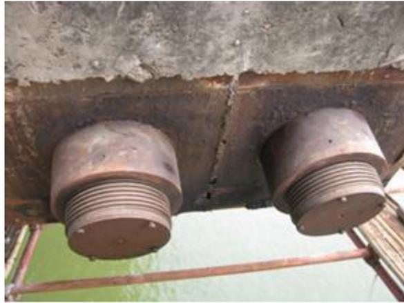
图 4.8-7 锚头锈蚀
