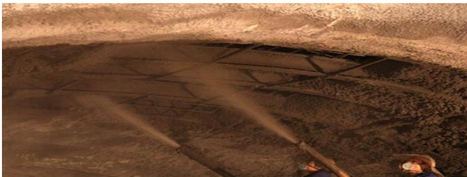
图 4.3-6 锚喷混凝土加固处理
