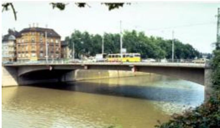
图 1.2-12 门式刚构桥实例
