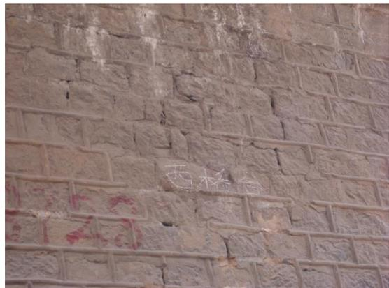
图 4. 4-2 砌缝渗水侵蚀
