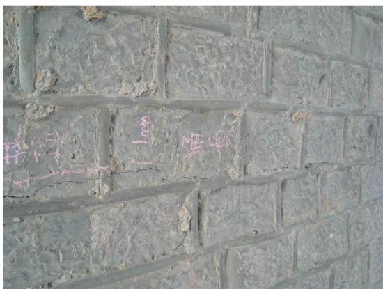
图 4.4-3 主拱圈拱顶横向裂缝
