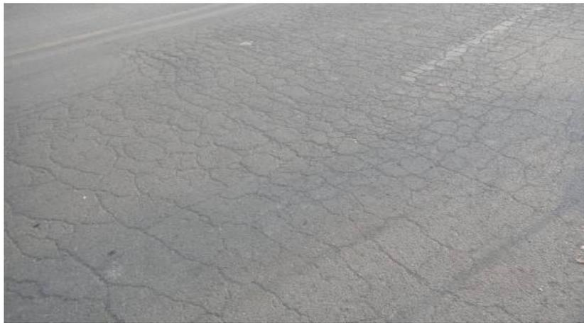
图 4.1-3 桥面铺装层龟裂
