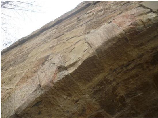
图 4. 4-1 砌石老化剥落
