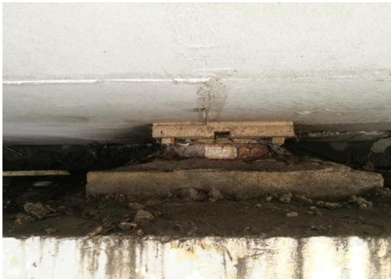
图 3.2.4-17 盆式橡胶支座外观检查
