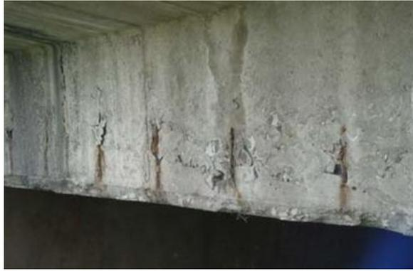
图 4.3-2 桥梁混凝土漏筋锈蚀
