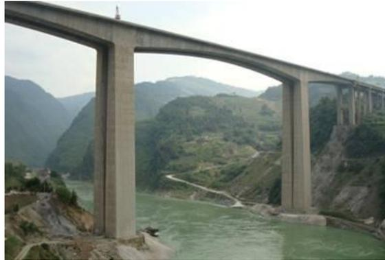
图 1.2-15 连续刚构桥实例
