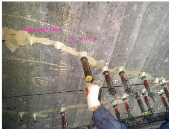
图 4.3-5 裂缝注浆处理
