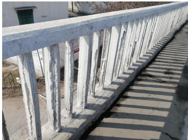
图6-5 护栏混凝土开裂、剥落、露筋锈蚀
