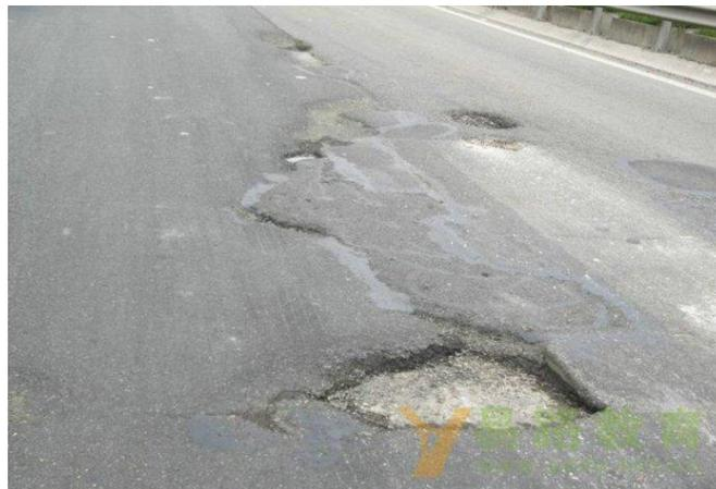
图 4.1-7 桥面铺装层坑槽
