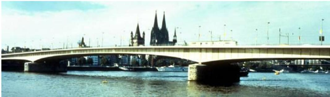
图 1.2-6 连续梁桥实例
