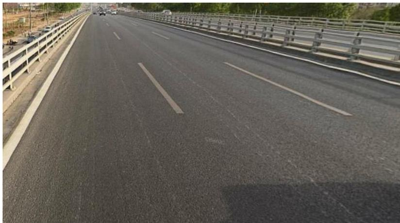
图 4.1-1 沥青混凝土桥面铺装
