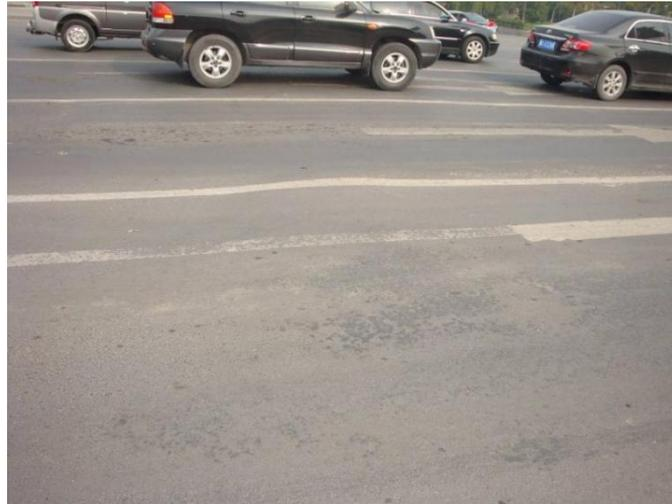
图 4.1-6 桥面铺装层拥起及车辙
