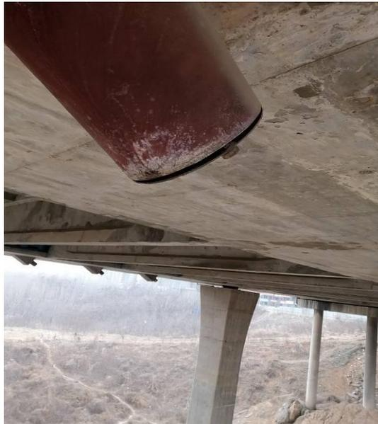
图 3.2.4-15 钢护筒外观检查
