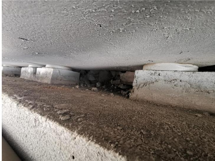
图 3.2.4-16 橡胶支座外观检查
