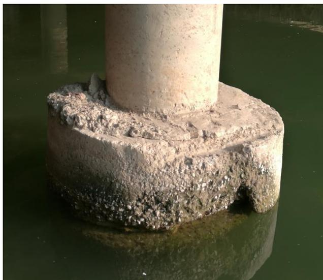
图 3.2.4-19 墩台基础外观检查
