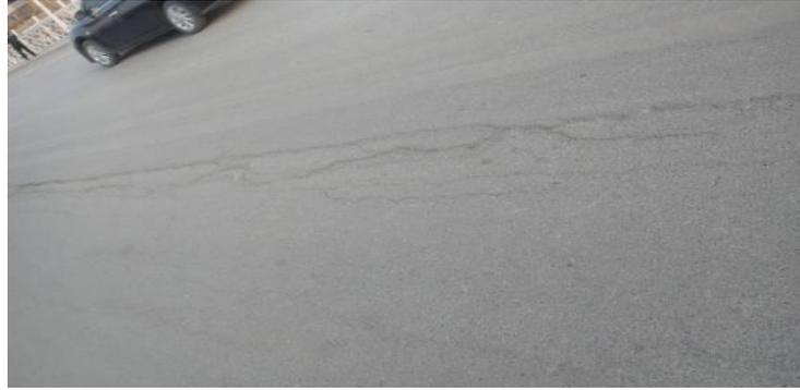
图 4.1-5 桥面铺装层纵向裂缝
