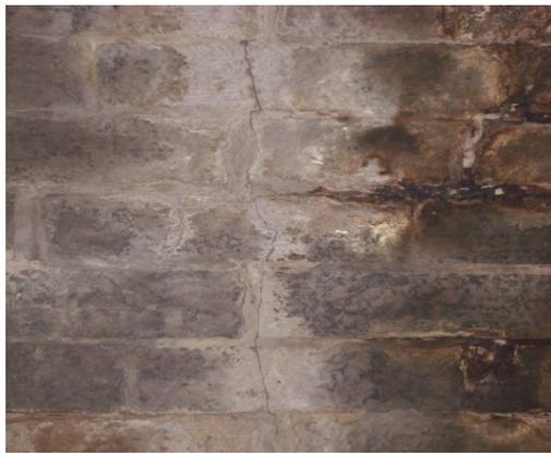
图 4.4-4 主拱圈拱顶纵向裂缝
