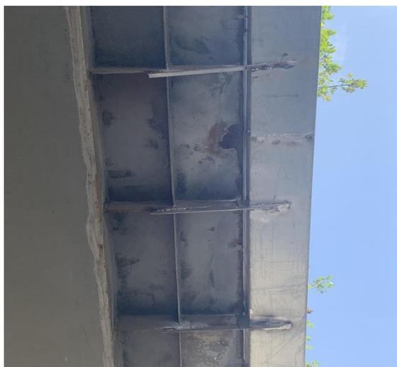
图 3.2.4-10 钢梁翼缘板钢板穿孔
