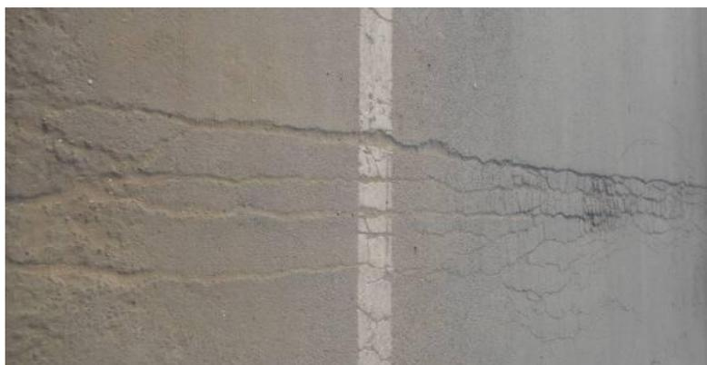
图 4.1-4 桥面铺装层横向裂缝
