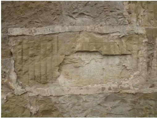
图 4.4-5 砌石表面老化磨损
