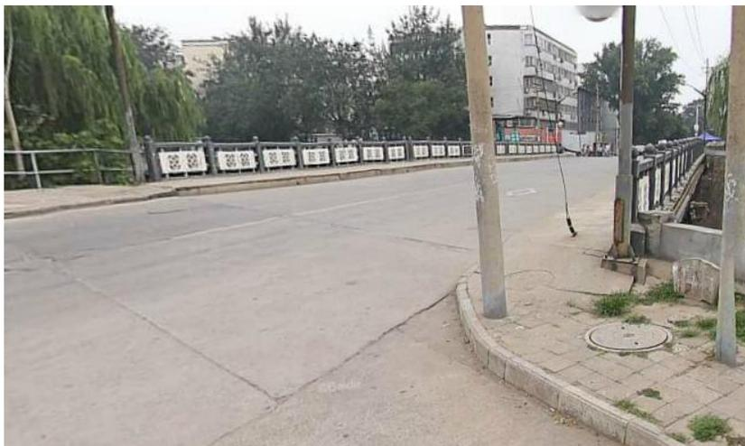
图 4.1-2 水泥混凝土桥面铺装
