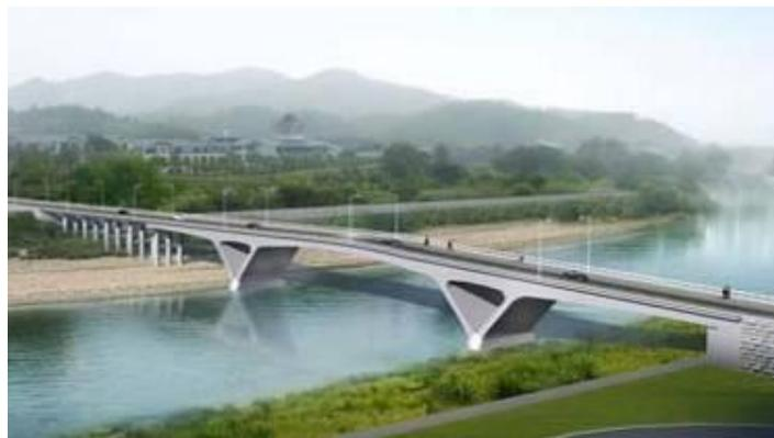
图 1.2-16 V 型墩刚构桥
