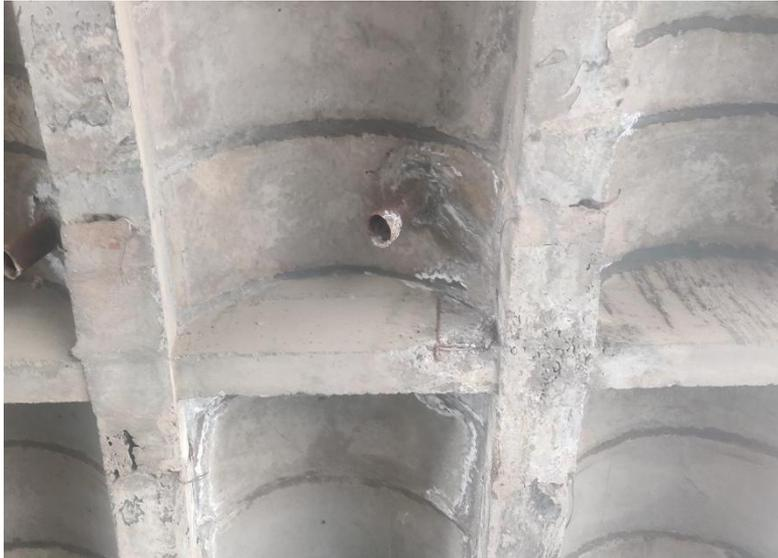
图 3.2.4-7 连接件病害检查
