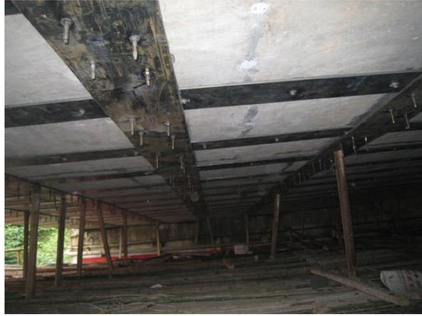
图 4.3-7 粘贴钢板加固处理
