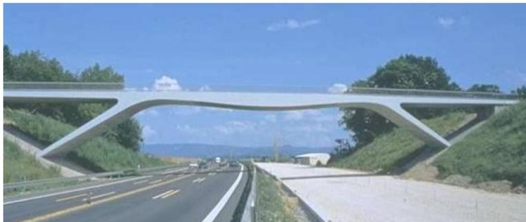
图 1.2-13 斜腿刚构桥实例
