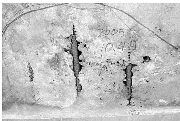
图 4.3-1 桥梁混凝土空洞露筋
