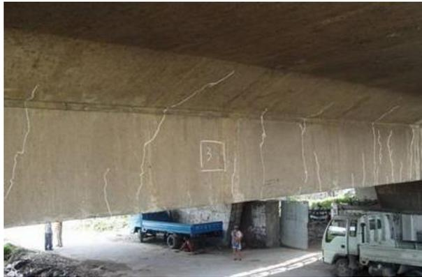
图 4.3-3 混凝土梁腹板裂缝
