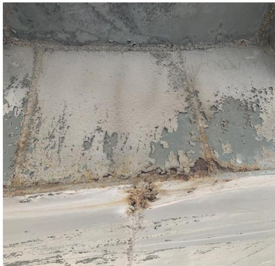
图 3.2.4-13 钢梁锈蚀检查
