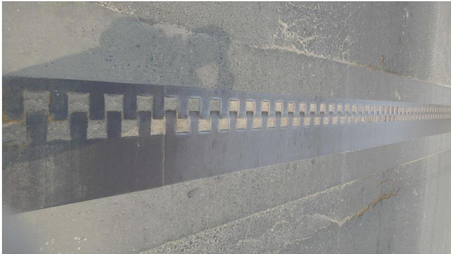
图 4.2-2 梳齿型伸缩装置
