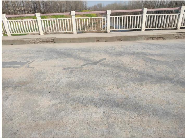
图 6-1 钢筋混凝土护栏
