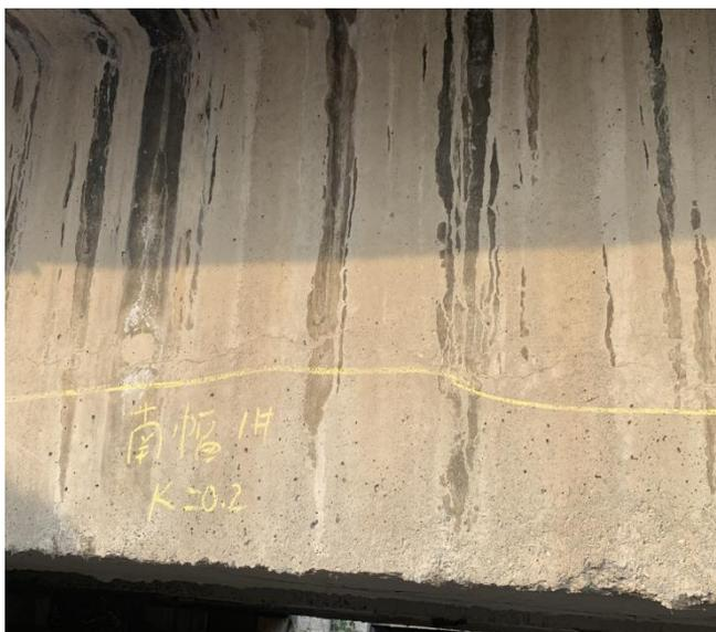
图 3.2.4-9 混凝土梁裂缝检查
