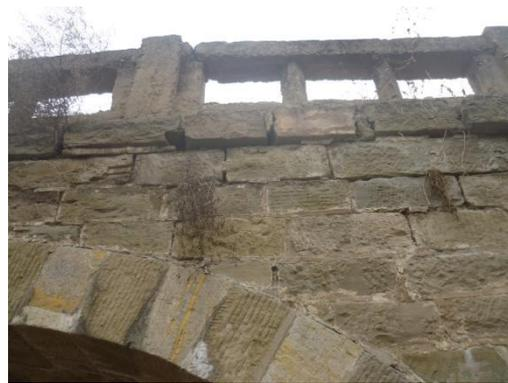
图 4.4-6 拱上建筑生物侵蚀
