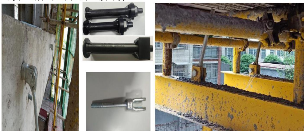
(a) 钢筋斜拉杆上拉端连接
