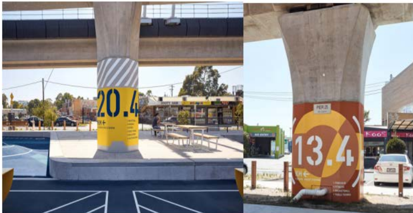
图 11 涂装装饰桥墩照片
