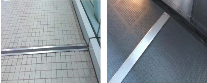
图 20 实桥伸缩缝照片
