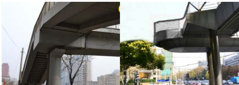
图8 梁端美化处理照片
