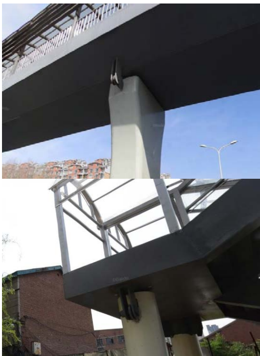
图 1 抗拉拔抗震措施示意图
