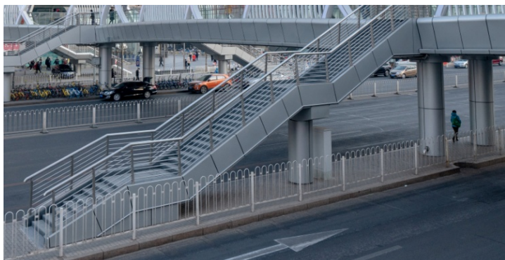
图 10 装饰板装饰桥墩照片
