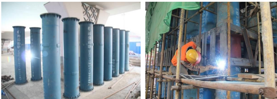
图 4-13 钢支撑现场安装照片
