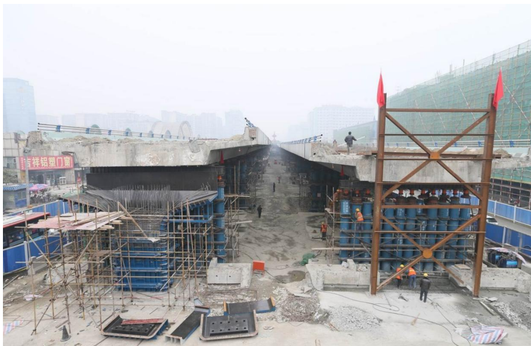
图 4-36 类似工程顶升施工过程
