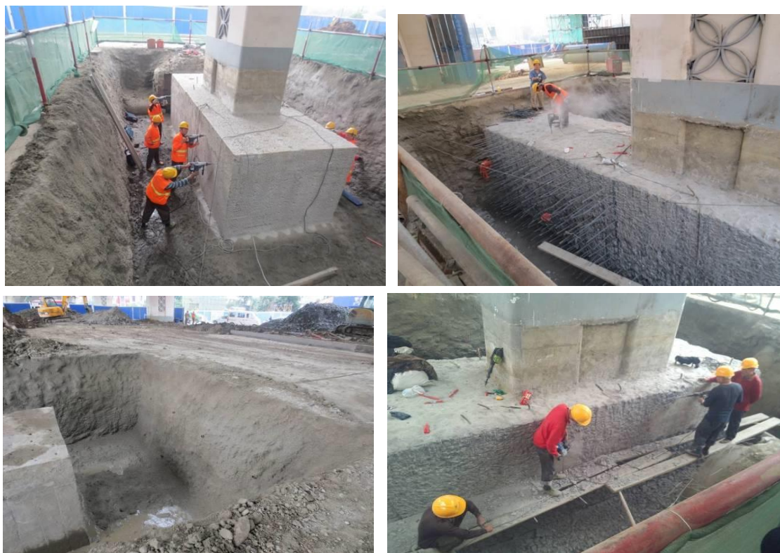
图 4-4 承台凿毛植筋施工照片
