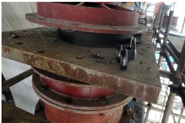
图 4-20 顶升设备安装现场照片
