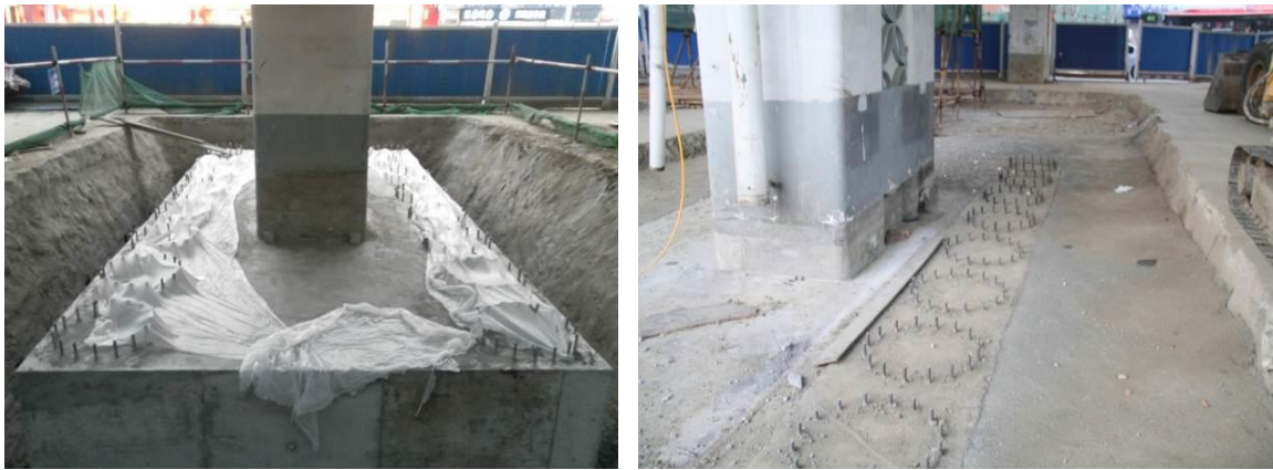
图 4-6 改造后承台养护照片
