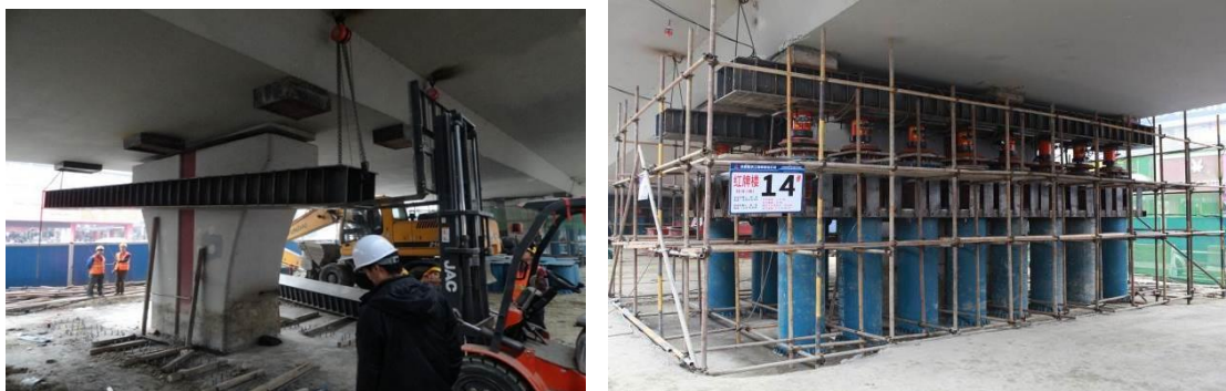
图 4-17 钢横梁安装照片
