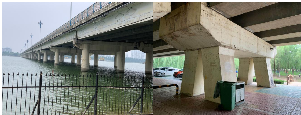
图 1-4 沂河桥现状照片
