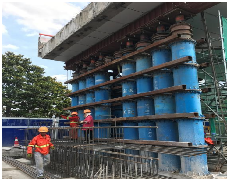
图 4-8 中墩顶升支撑布置图
