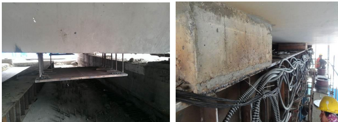
图 4-15 梁底照片施工照片
