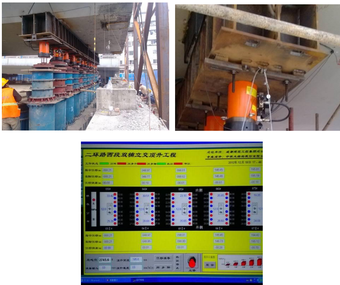
图 4-34 试顶升现场施工照片
